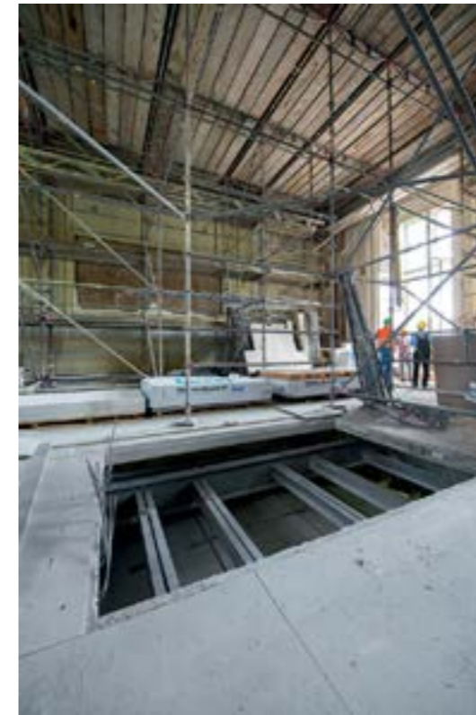
Das Bauen im Bestand bei laufendem Betrieb birgt unzählige Unwägbarkeiten.
