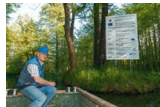
Bauprojekte im Spreewald unterliegen besonderen Bedingungen. Polier Werner Urban von der TWB Boblitz fährt mit dem Prahmen zur Baustelle.
