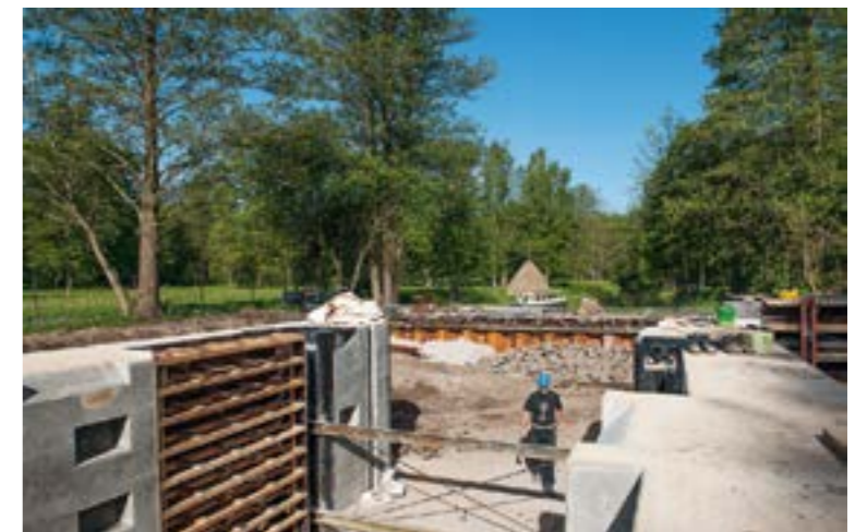
Oben: Die linke Schleusenkammerwand ist fast 22 Meter lang.
