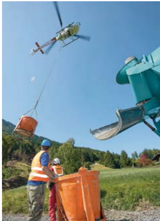
Vorbereitung auf den nächsten Einsatz: Zwei Fahrmischer und zwei Kübel, die abwechselnd befüllt werden, sichern den kontinuierlichen Ablauf.
