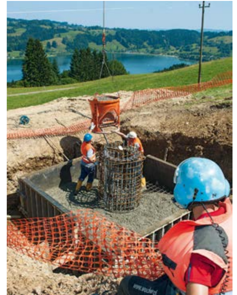
Von der festen Baustelle wird der Beton in das unzugängliche Gelände am Steigbach befördert.
