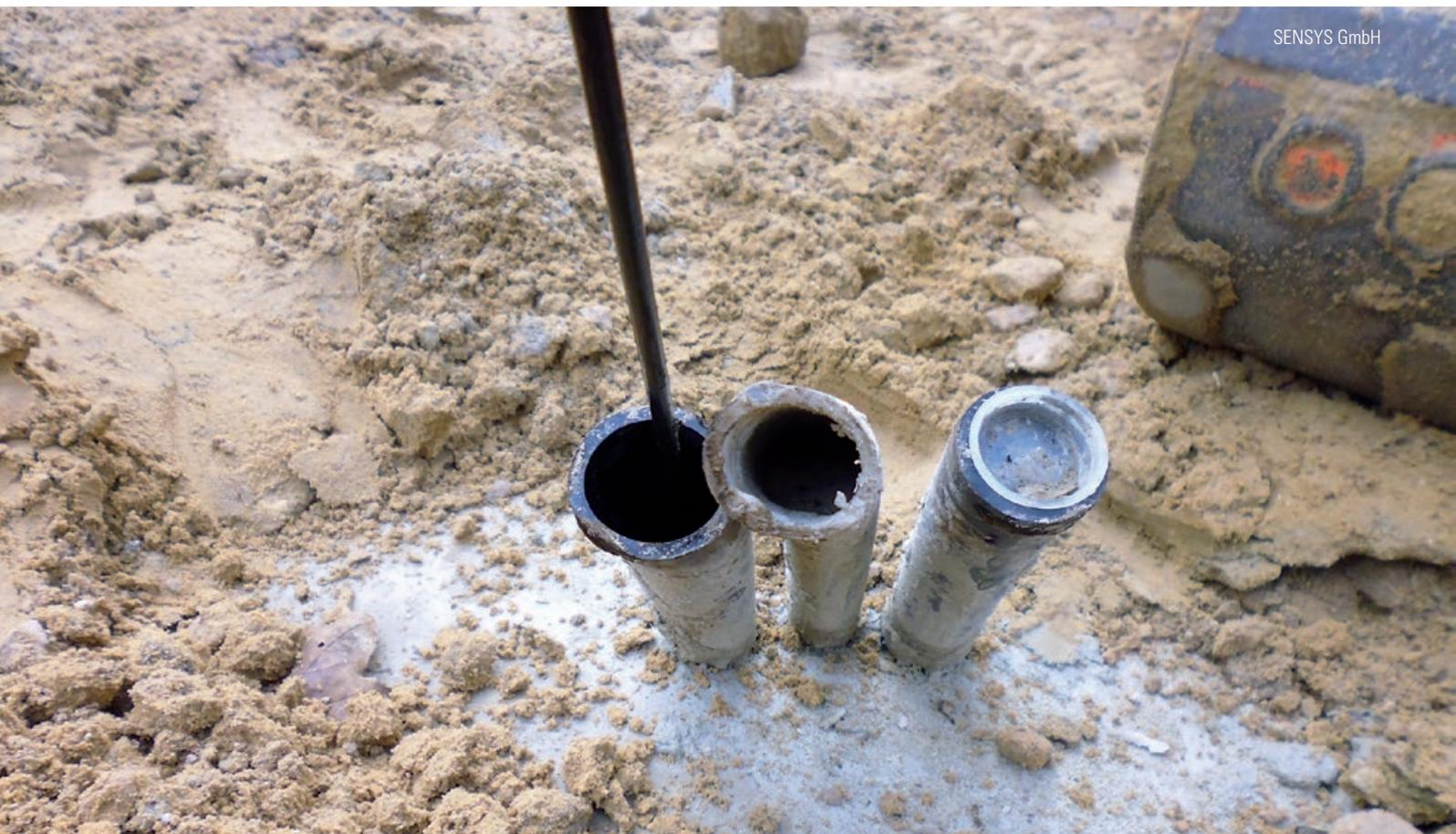
CONTRÔLE DE NIVEAU DE REMPLISSAGE AVEC THERMOCEM® PLUS MAGNÉTIQUE DOPÉ
