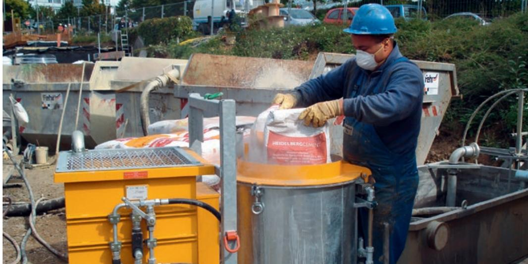
**Les mélangeurs à petite vitesse sont principalement conçus pour les matériaux à granulométrie continue dont la consistance permet aussi le pompage. Les mélangeurs en continu sont généralement utilisés sur les chantiers de géothermie. En fonction du mélange réalisé, la qualité de la suspension ThermoCem peut être suffisante. Il est toutefois recommandé de faire un essai de convenance lors de l'achat d'une nouvelle machine.**
