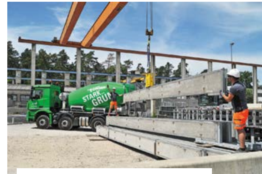
Zur zielsicheren Herstellung von robusten Schutzwänden mit hohem Frost- und Frost-Tausalz-Widerstand lieferte die Heidelberger Beton GmbH einen Spezialbeton.
