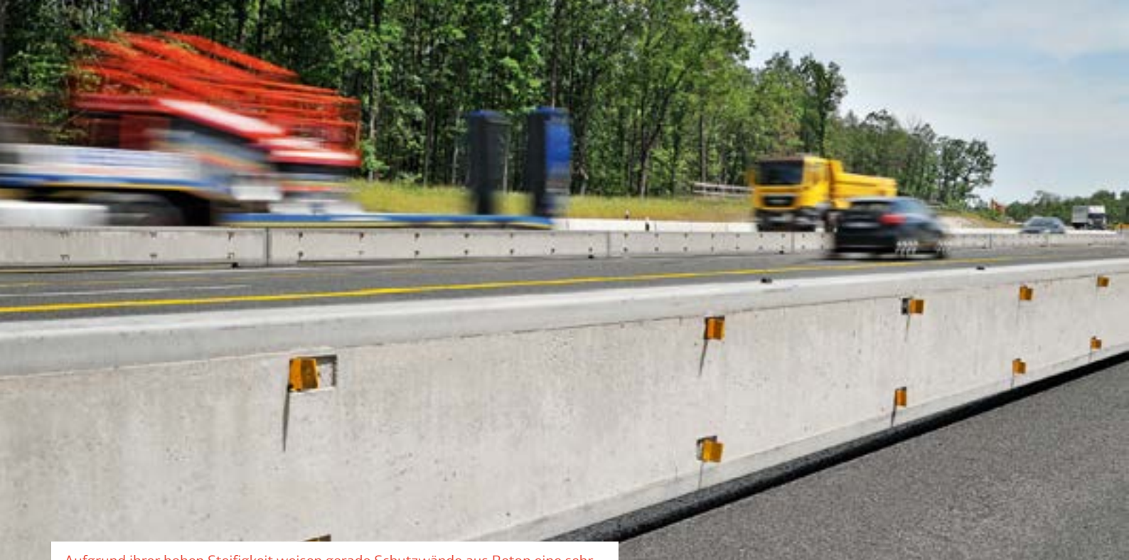
Aufgrund ihrer hohen Steifigkeit weisen gerade Schutzwände aus Beton eine sehr hohe Durchbruchssicherheit auf. Von der Fahrbahn abkommende Fahrzeuge werden aufgehalten und abgelenkt, ohne die Wand zu durchbrechen.
