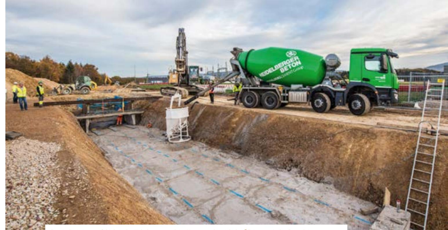
Damit die Leistungsfähigkeit der Kabeltrasse auch im Kreuzungsbereich der Ölleitung mit der Stromleitung gewährleistet ist, wurde hier der patentierte, hochwärmeleitfähige Spezialbeton Powercrete als Bettungsmaterial eingebaut. Durch seine hohe Wärmeleitfähigkeit wird die entstehende Wärme in diesem Bereich gut abgeführt und die Leitertemperatur effizient reduziert.
