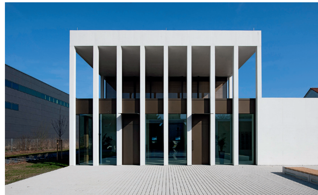
Stützen charakterisieren den Kirchenbau. Diese relevanten Bestandteile sakraler Architektur dienen in Neuhausen auch profanen Zwecken: Sie verschatten den Kirchensaal, integrieren Fallrohre, Blitzschutz und Leitungen für die Elektrik.
