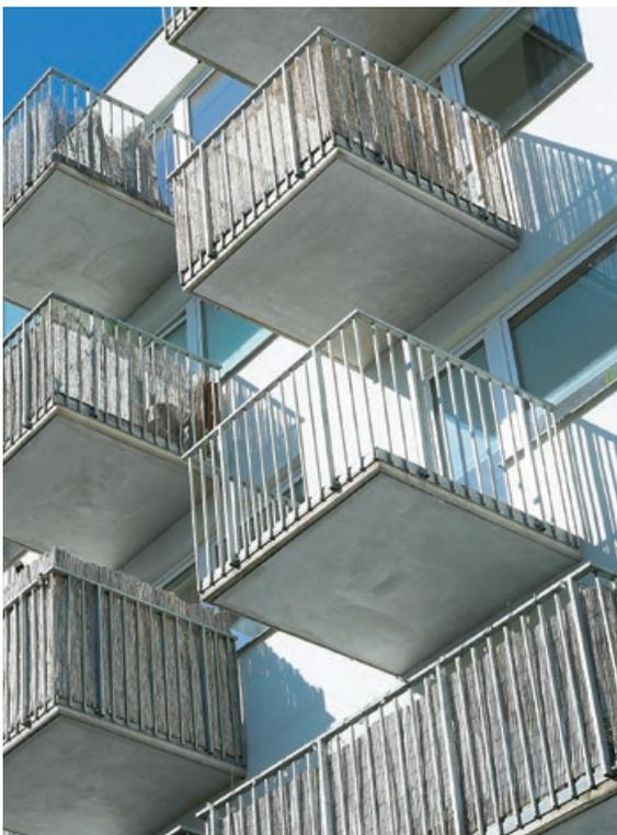
Ultrahochfeste Betone werden extremen architektonischen Herausforderungen gerecht: Sie bieten sowohl architektonisch innovative Lösungen, z.B. im Brückenbau, besitzen aber auch einen einfachen, praktischen Nutzen, z. B. für schlanke Balkonkonstruktionen.
