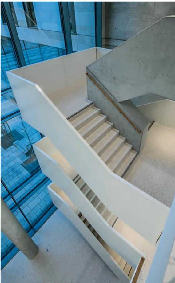
Der UHPC-Compound EFFIX® PLUS ermöglicht die einfache Herstellung solcher Hochleistungsbetone und bietet aufgrund seiner besonderen Eigenschaften enorme Vorteile – für den Fertigteilproduzenten, aber auch für den Architekten durch die vielseitigen Einsatz- und Gestaltungsmöglichkeiten. So entstehen filigrane, sehr belastbare, vor allem aber widerstandsfähige Bauteile wie Treppen, Balkone, bis hin zu Brücken.
