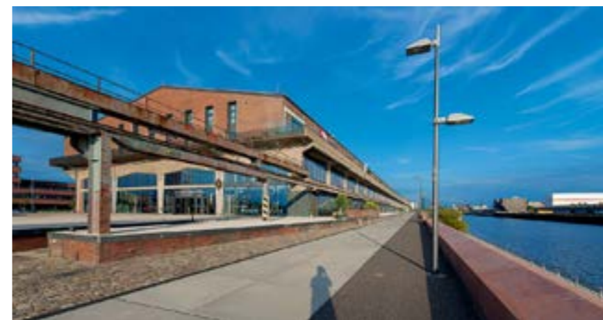
Mit dem Erhalt historischer Bausubstanz wie dem „Schuppen Eins“ bleibt der Charme und die Atmosphäre des ehemals bedeutenden Hafens auch im neuen Stadtteil Überseestadt spürbar.
