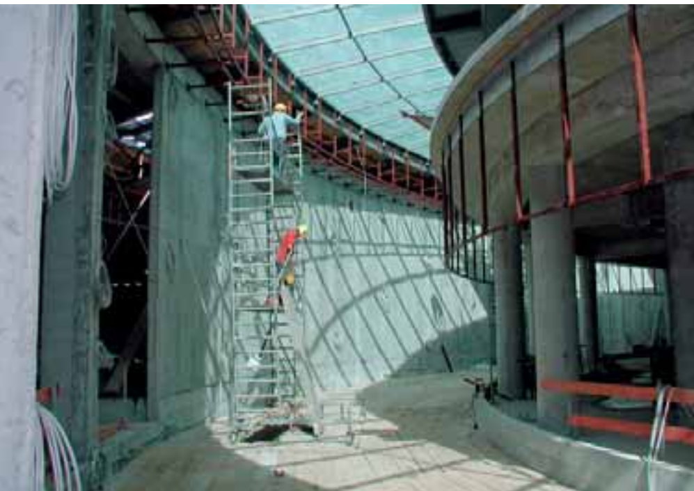
Bauarbeiten im Innenbereich des Einkaufszentrums: Ab Frühjahr 2007 ist der Bau zum Flanieren freigegeben.
