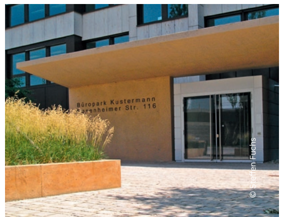
Gelber Sichtbeton; Büropark Kustermann, München, Kluska und Erhard Architekten, München
