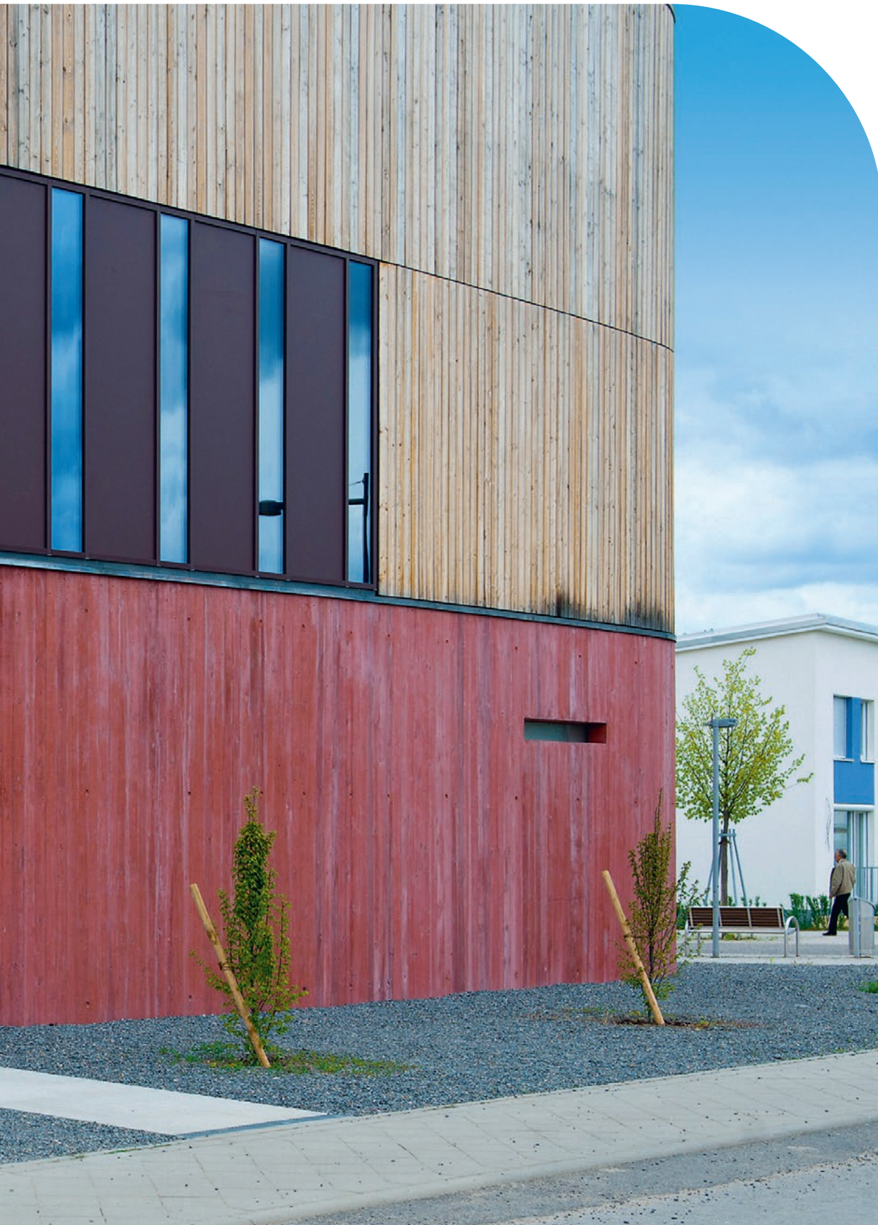
Roter Sichtbeton; Lukaskirche, Heidelberg AAG Loebner, Schäfer, Weber BDA, Freie Architekten GmbH
