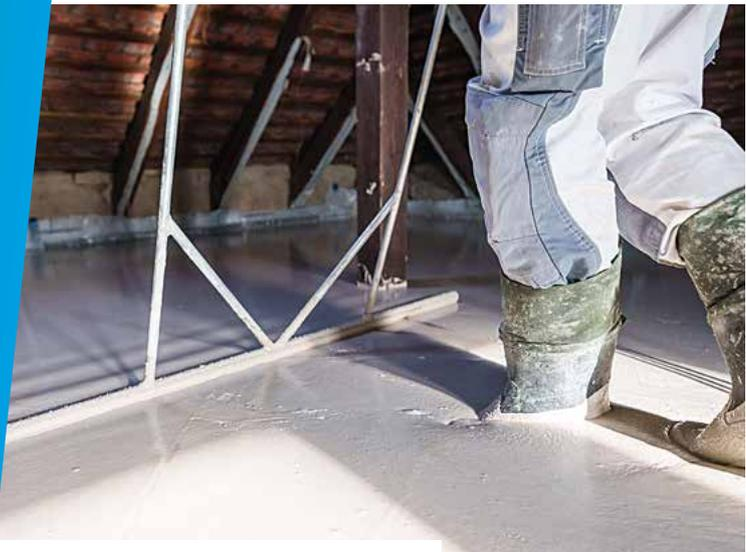
Als Estrich für die Fußbodenheizung wird der innovative Anhyment Slim der Heidelberger Beton eingebaut.
