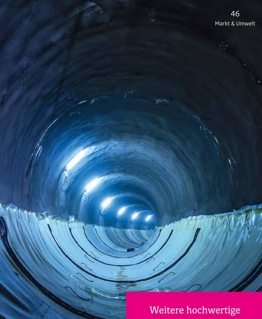
Die Tunnelinnenschalen verhindern in Verbindung mit einem Abdichtungssystem den Eintritt von Bergwasser.
