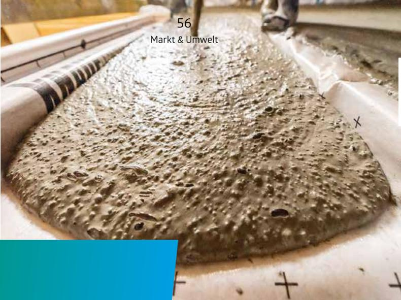
Der Poriment P umschließt verlegte Versorgungsleitungen vollständig.
